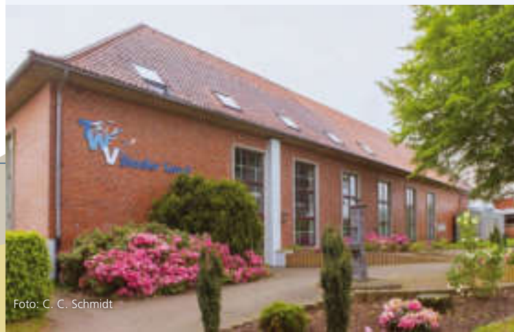
Die Zentrale des Trinkwasserverbandes (TWW) Stader Land in Dollern. Der TWW verfügt über die Wasserwerke Dollern, Heinbockel und Himmelpforten, in denen jährlich insgesamt 7,3 Millionen Kubikmeter Wasser gefördert werden.
